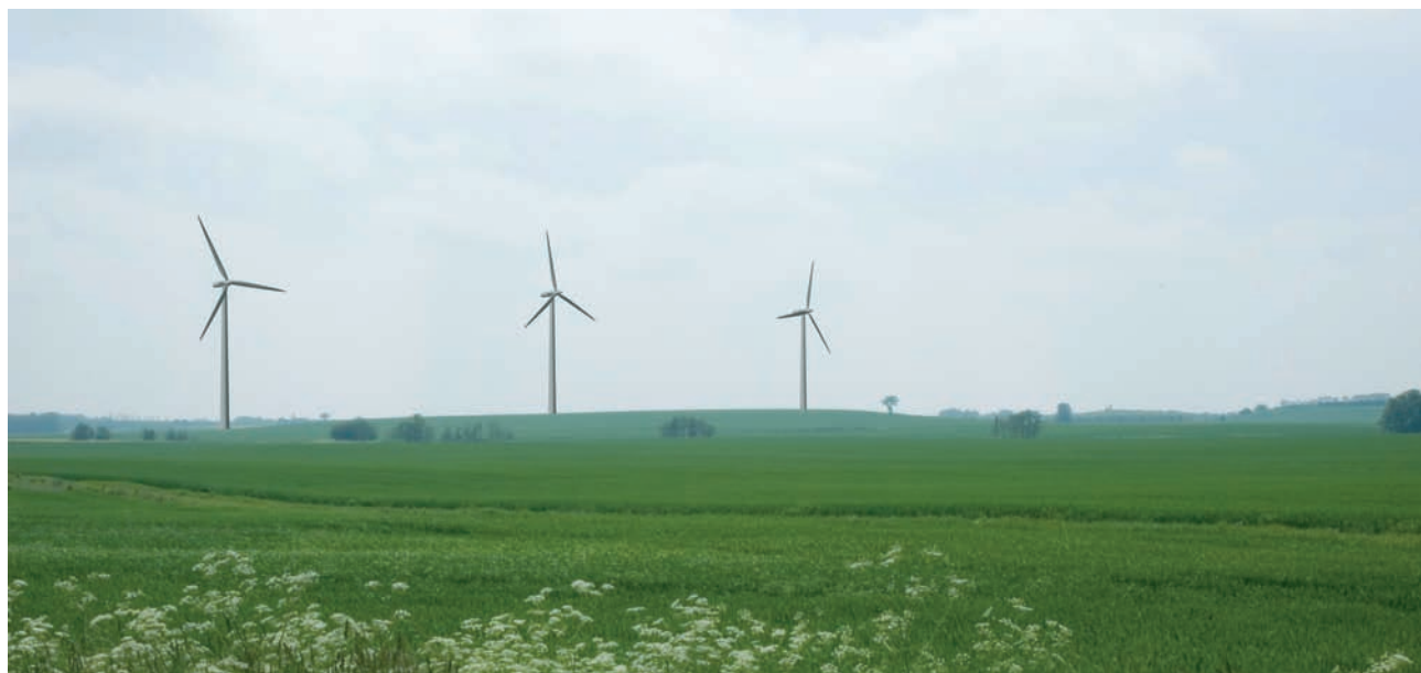
3 stk 2,3 MW møller med en totalhøjde på 125 m, afstand 1-1,3 km
