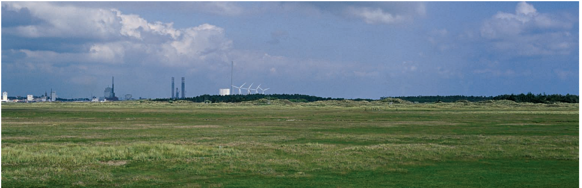
Esbjerg Havn, standpunkt 1. Afstand til nærmeste mølle omkring 5,1 km
