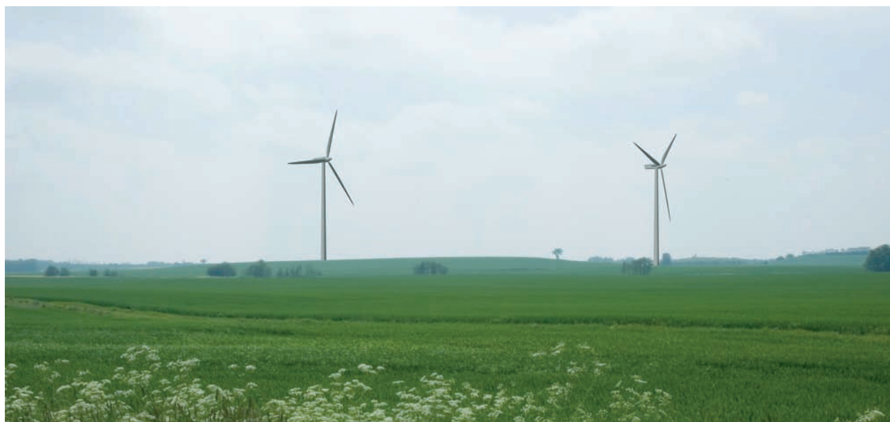
2 stk 3,6 MW møller med en totalhøjde på 150 m, afstand omkring 1 km
