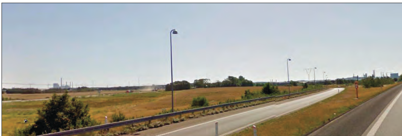
Foto fra motorvejen set fra nord. Areal til erhverv ligger i det flade landskab bag eksisterende erhvervsområder.
