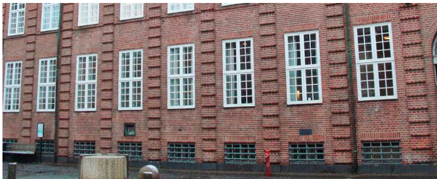
Sorø bymidte har en smuk bygningsarv, men de lukkede facader og høje vinduer betyder, at oplevelserne i bylivet forringes.
