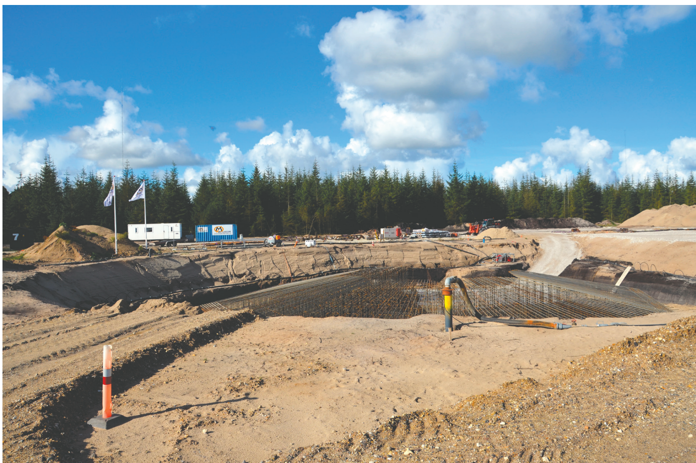
Etablering af fundament - eksempel fra Østerild Testcenter
