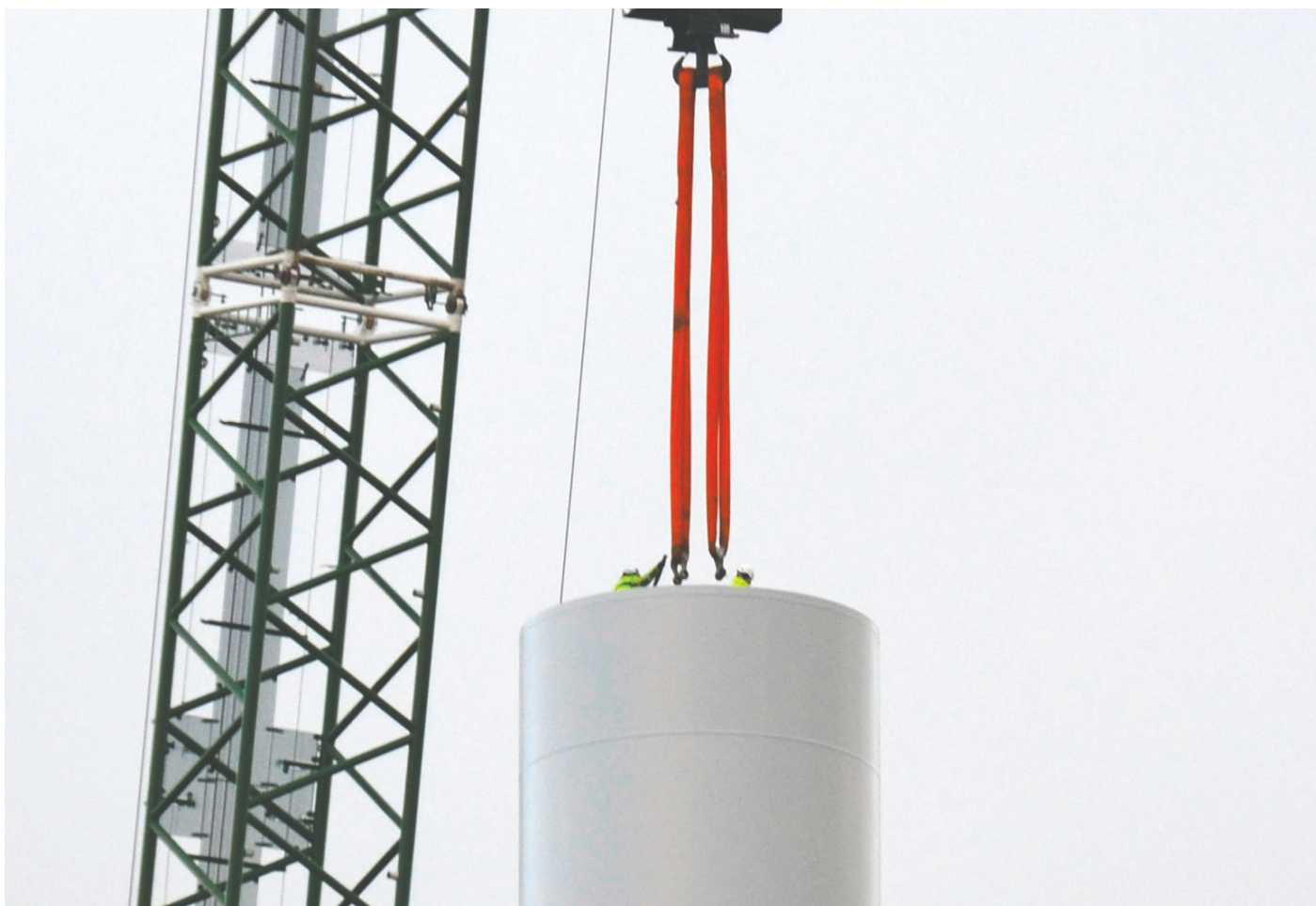
Montering af tårnsektion med kran
