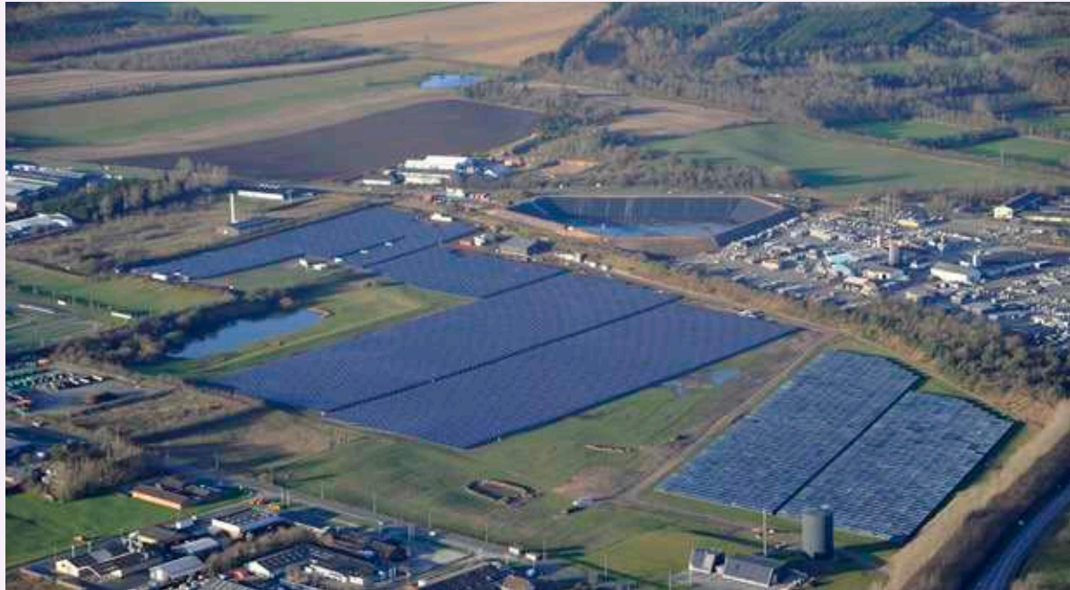
Solfangeranlæg ved fjernvarmeværket i Vojens dækker et stort areal. Foto: Vojens Fjernvarme
