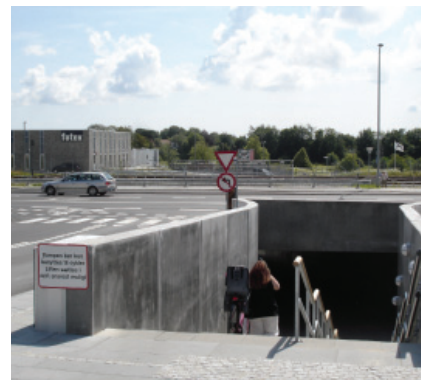
Det nyeste butikscenter, Bispetervet, i baggrunden ses bl.a. Føtex. Trods en ny fodgængertunnel er der svag sammenhæng til bymidten.
