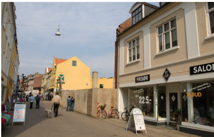
Eksisterende forhold ved Guldborgkarréen, maj 2011.
