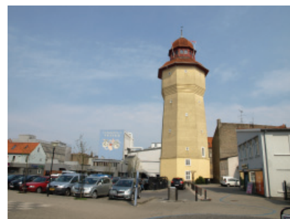
Vandtårnet, byens vartegn, var den hidtil største jernbetonkonstruktion i Danmark i 1908.
