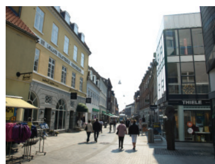
Ny belægning i Østergågade.
