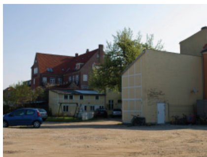
Eksisterende forhold i den nordlige del af Postgårdkarréen. Set fra parallelgaden.
